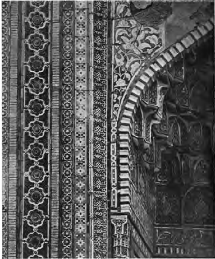
Fig. 9. — Entrée d'un sanctuaire de la mosquée de Chah Sindh à Samarkand. Mosaïque de pièces de céramique en revêtement. Décor par opposition de couleurs.
